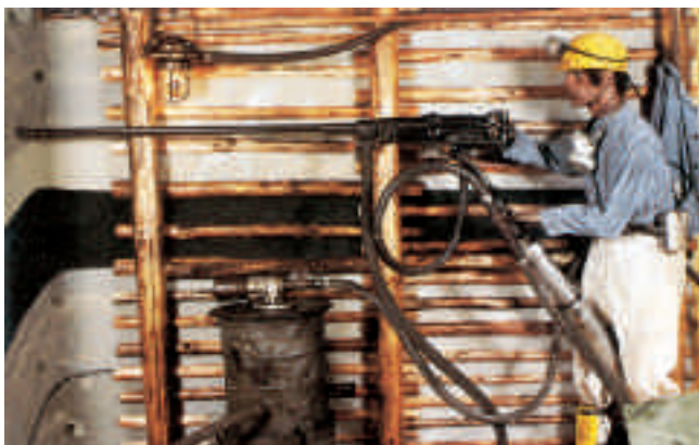
Sprenglochbohren
